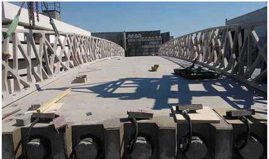
Voorraanzicht van het brugdek met voorspanning.
