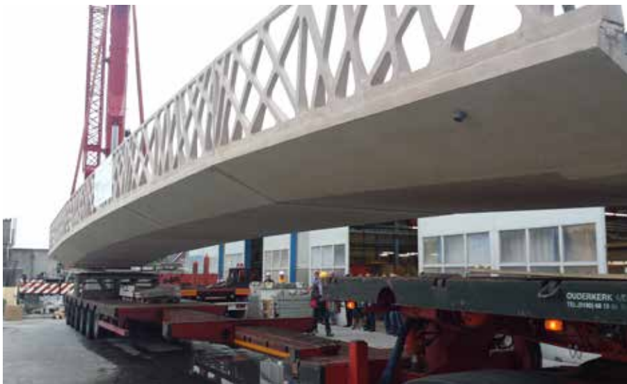
Transport van het dek als een geheel naar de definitieve locatie.
