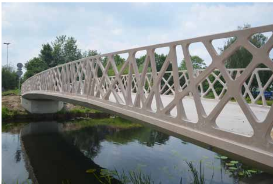
De Ultrabrug bij de zwaaikom in Eindhoven verbindt twee fietspaden aan weerszijden van het Eindhovens Kanaal.
