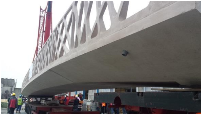
Fig. 18 Transport van het brugdek naar locatie per vrachtwagen
