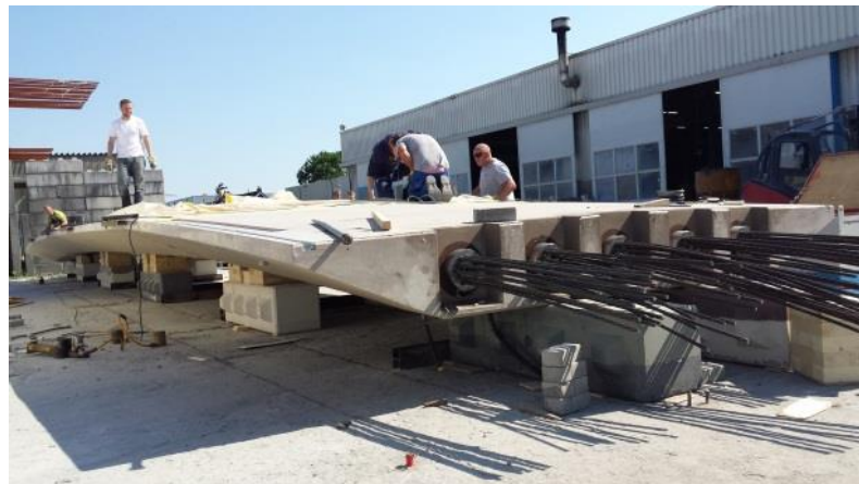
Fig. 4 Opbouw van voorspanning kanalen in het brugdek
